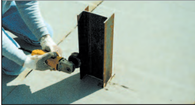
Aplicación de tapajuntas Parapro 123 SOBRE la capa de acabado
